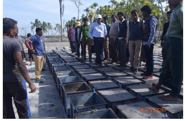
বাপাউবোর চীফ মনিটরিং মহোদয়ের প্রতিরক্ষা কাজের পরিদর্শন
